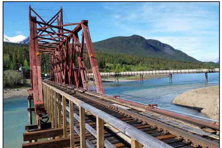
Un pont ferroviaire étroit construit vers 1900, près de Carcross, au Yukon, au Canada. Photo : Dan Dyck.
