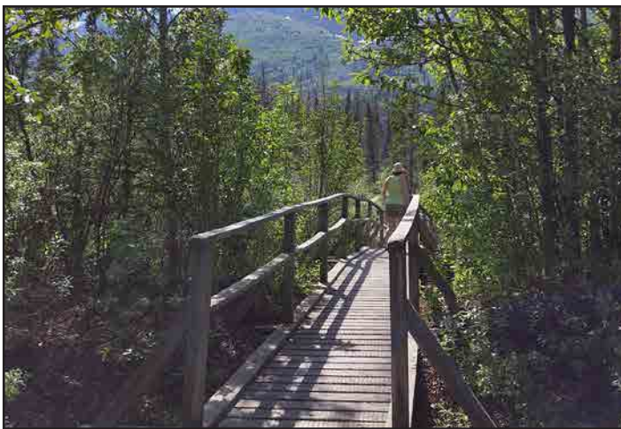
Un pont au travers d'un ravin qui peut se remplir lors de la fonte des neiges ou lors de fortes pluies, sur le sentier du glacier Rock dans le parc national de Kluane au Yukon, au Canada. Photo : Dan Dyck.
